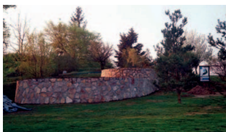
... a po rekonstrukci (2009)
